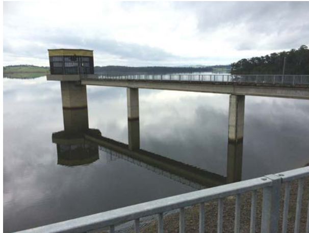
Figure 1. — Captação da barragem Blue Rock
